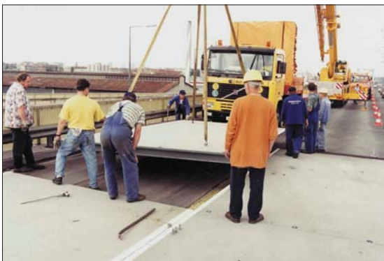
Bild 14. Die neue Fingerdilatation der Firma Reisner & Wolff mit den Grundplatten, auf denen die austauschbaren Fingerplatten fixiert sind. Dazwischen befindet sich die Elastomerrinne Fig. 14. The new finger expansion joint by Reisner & Wolff with the basis plates and the exchangeable finger plates; in between the elastomeric gutter.
