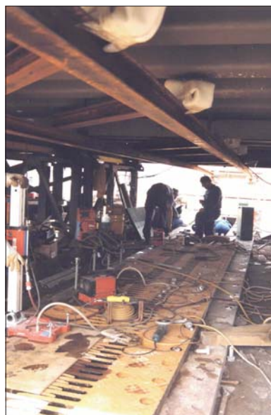
Bild 16. Die neue Fingerdilatation der Firma Reisner & Wolff nach dem Einrichten der Grundplatten, auf denen die Fingerplatten fixiert wurden Fig. 16. The new finger expansion joint by Reisner & Wolff after positioning the basis plates and fixing the finger plates
