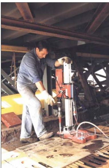
Bild 15. Die Grundplatten der Fingerdilatation wurden mittels Ankerschrauben in der Betonkonstruktion fixiert Fig. 15. The basis plates are fixed by anchor bolts in the concrete construction
