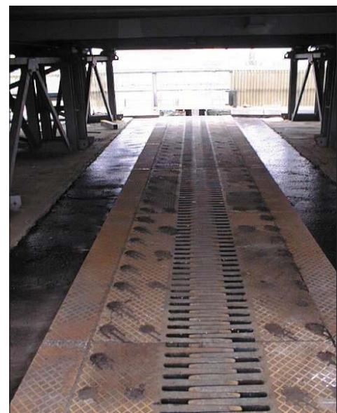
Bild 17. Der abgeschlossene Austausch der Dilatation der Firma Reisner & Wolff Fig. 17. The finished exchange of Reisner & Wolff's finger expansion joint
