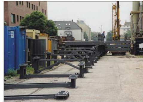
Bild 9. Die Böcke, auf denen die Fahrbahnplatten gelagert wurden, während der Probeaufstellung Fig. 9. The trestles supporting the deck elements during the test erection
