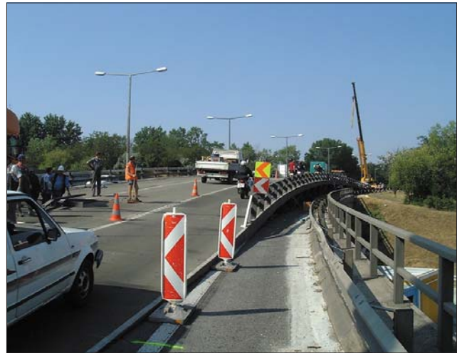
Bild 6. Die erste Aufstellung 2001 während des Aufbaus mit einem Radius von 250 m, einer Steigung der Fahrbahn von 4,5 % mit Querneigung
