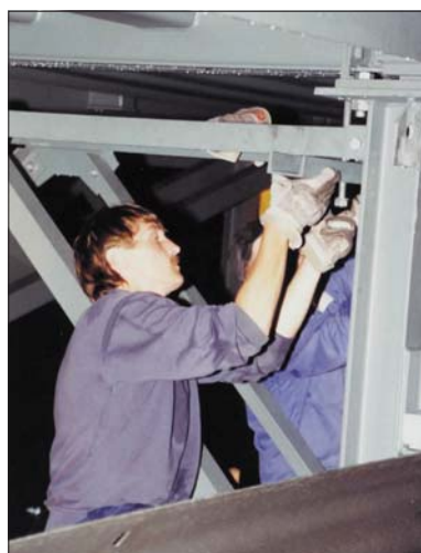
Bild 11. Einfache Schraubverbindungen sichern die Fahrbahnelemente Fig. 11. Simple bolt connections
