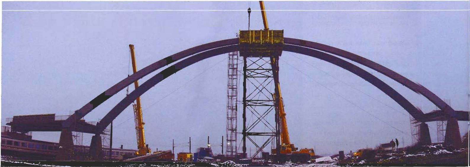
Montageplatz verschweißt. Gleichzeitig wird ein Hilfsgerüst in Bogenmitte als provisorisches Mittellager mit einer Arbeitsplattform „in luftiger Höhe“ aufgestellt und nach vier Seiten abgespannt.
